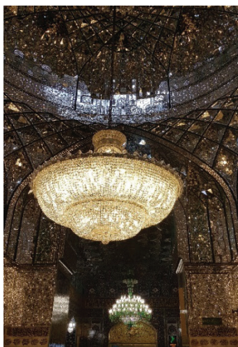
تصویر ۱۱- سقف آیینه‌کاری همراه با کاربندی و سقف کاشی‌کاری همراه با مقرنس‌کاری، روضه منوره (ماخذ: نگارندگان).
