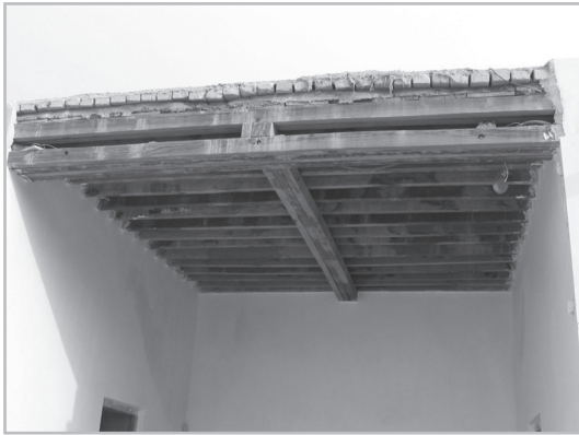
تصویر ۱۳: پوشش چوبین سقف تالار اجتماعات (نگارنده)
