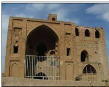
شکل ۲: نمایی کلی از بنای بقعه پیربکران (پرویز، ۱۳۸۹: ۱۲)
