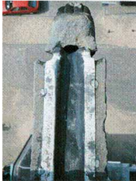
تصویر (۱): سیستم دفع آب باران از سقف توسط گرگویل، کلیسای آمین، فرانسه.
